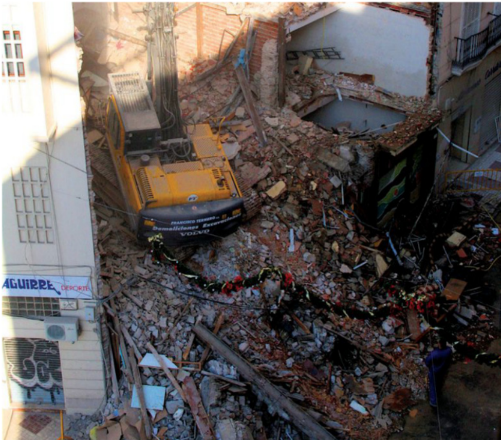
Demolición de un edificio de viviendas. Foto de Juan Pablo Olmo (Flickr).
