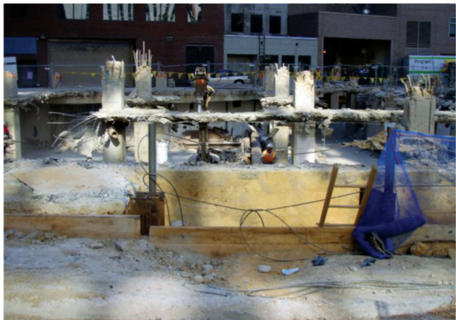
Los desechos de demolición se usan para obras de construcción, una vez que se reciclan. Foto de Daniel Lobo (Flickr).
